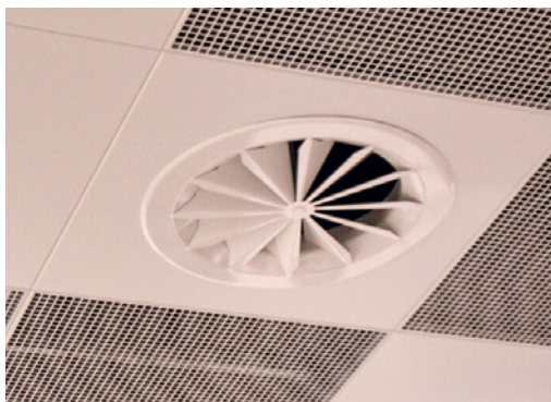
[FIG. 1] Système de distribution d'air à diffuseur radial RA-N de Durrer Technik / Krantz.
